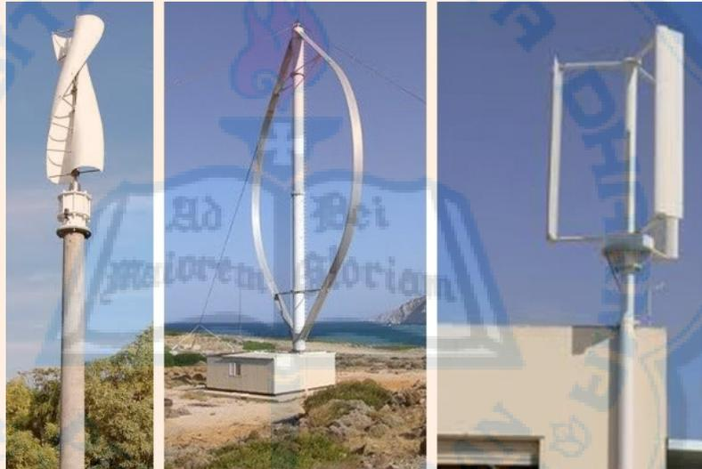
Gambar 2. Dari Kiri ke Kanan: Savonius, Darrieus dan Giromill
