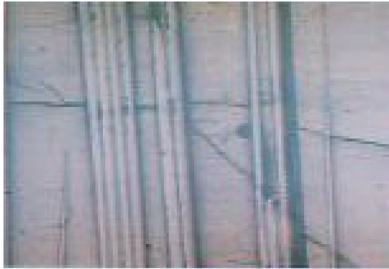
Gambar 4.11. Kerusakan debonding pada Komposit.
