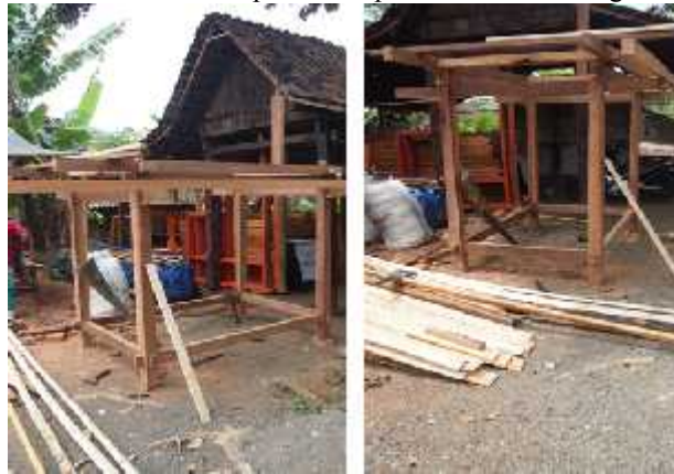
Gambar 5. Komponen Penyangga Atap Rumah Adat Using
