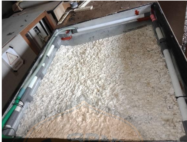
Gambar 2.9 Water distribution line tampungan atas
