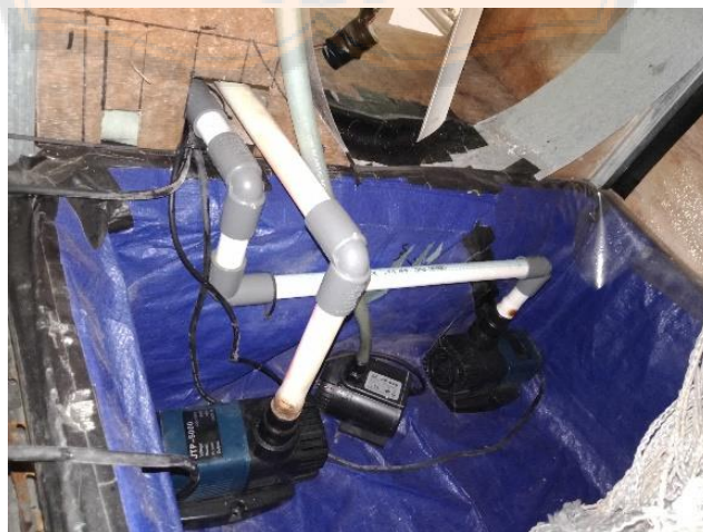
Gambar 2.8 Water distribution line tampungan bawah
