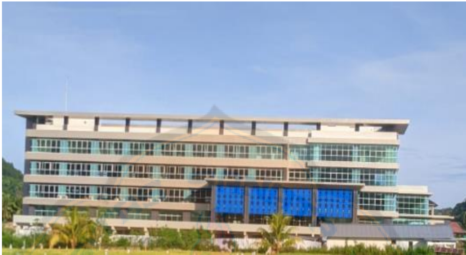
Gambar IV. 4 Sisi Kanan Gedung Baru RSUD Komodo
