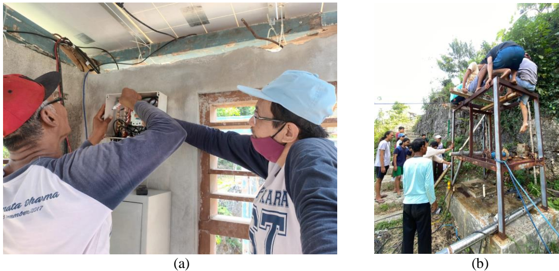
(a) (b) Gambar 5. Pengerjaan Instalasi Kelistrikan. (A) Pemasangan Panel untuk Instalasi Kelistrikan dan (b) Instalasi Kelistrikan di Sumur Bor.
