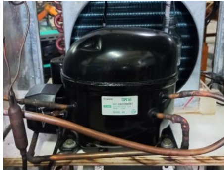
Gambar 3.2 Kompresor Fuji-Kobe SR16 ½ PK
